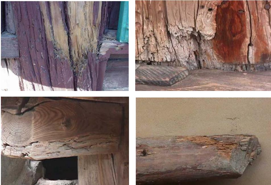
사진 2. 흰개미에 피해를 받은 각종 국보급 문화재 (A. 불국사 대웅전, B. 봉정사 대웅전, C. 임청각 군자정, D. 은혜사 영산정).
