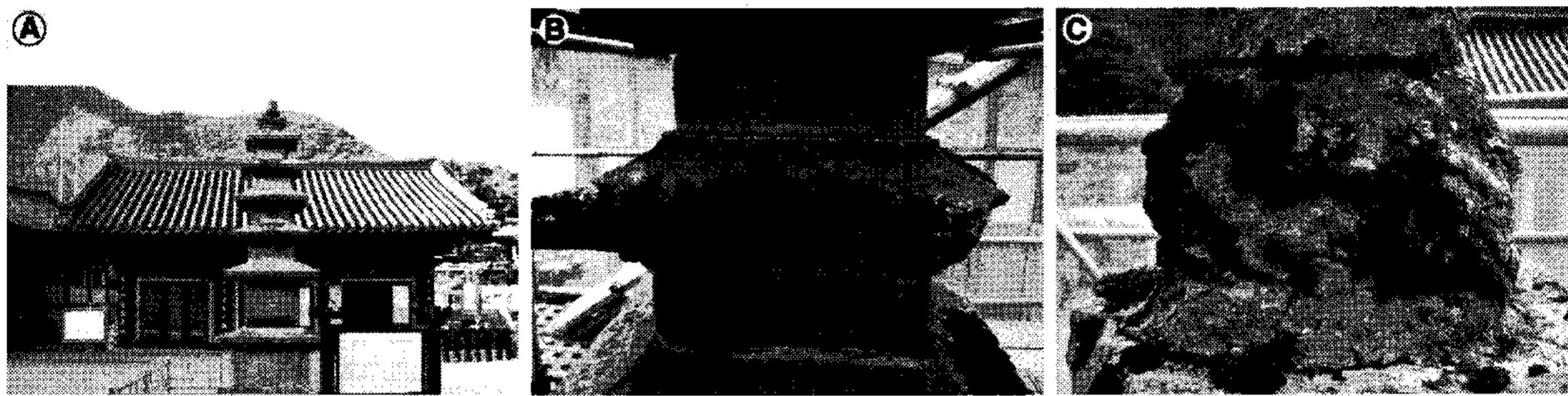
그림 1. 보경사 오층석탑의 현황. (A) 석탑의 전경. (B) 옥개석의 탈락 및 표면의 생물오염. (C) 시멘트 모르타르로 접합된 양화의 모습.
