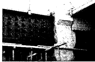
그림 6. PC기둥과 철골보 접합부
