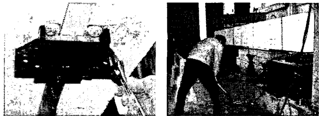
그림 4 긴장장치 설치 및 CFRP 판 긴장작업
