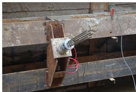
그림 8. 경원선 3공구 시험시공 전경
