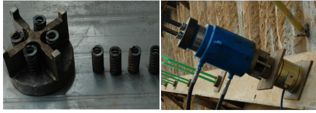
(c) 간격유지구 및 스프링 (d) 시공 전경
