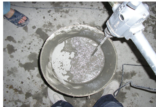
<그림 2> 핸드 믹서를 이용한 모르타르 배합
