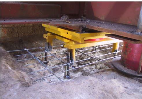
(c) 설치 중인 디스크 받침 (가동단)
