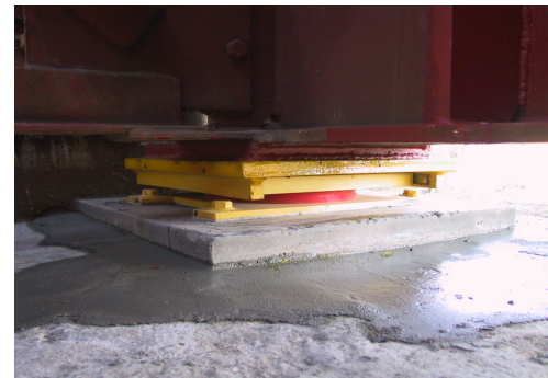
(d) 설치 완료한 디스크 받침 (가동단)
