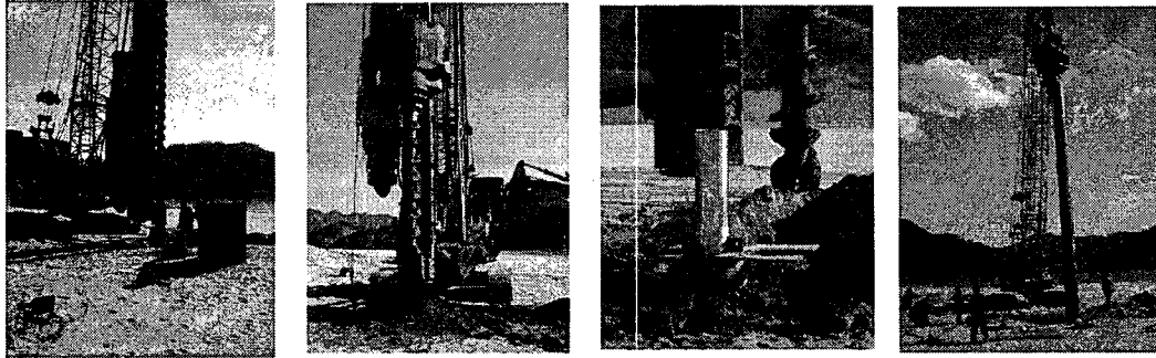
(a) 외부케이싱 설치 (b) 굴착 (c) 내부케이싱 설치 (d) 외부케이싱 인발 사진 1 충적층 시범 대형관정 설치 공사 사진
