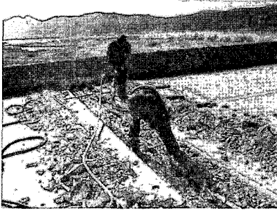
그림 4. 상판분리작업의 모습
