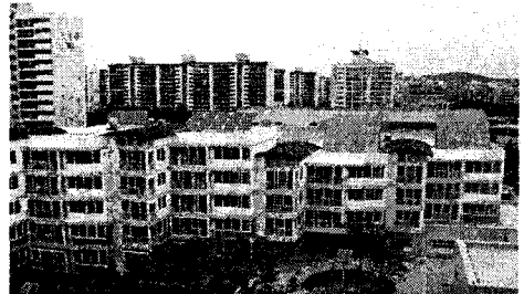
그림 1. 태양열 집열판 및 태양전지 설치 장면
