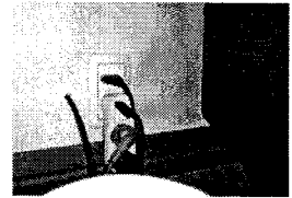
그림 18 고정형 콘센트의 접지극 유무 그림 19 화상대화방의 접지극 없는 고정형 콘센트의 일례
