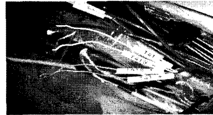
그림 6. 전동기 온도 측정용 케이블
