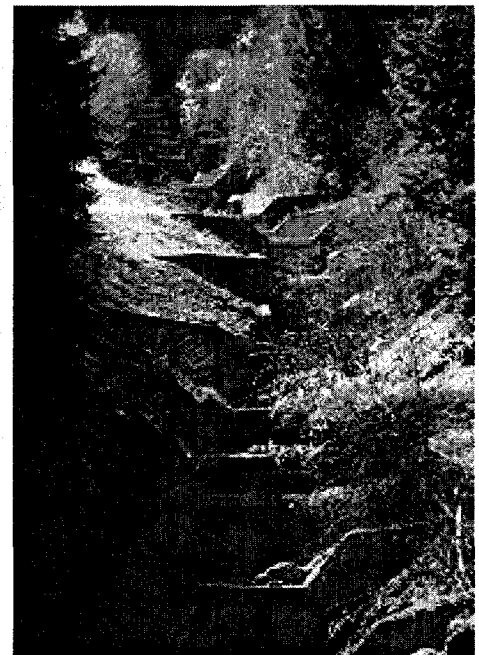
그림 8. 체크댐 설치(例)
