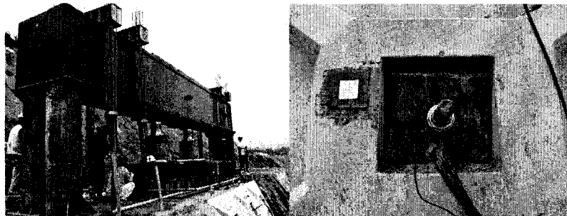
(e) 반력앵커 연결 및 측정점 설치 작업
