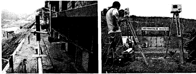
(f) LVDT 및 광파기측량/레이저스캐닝 설치작업
