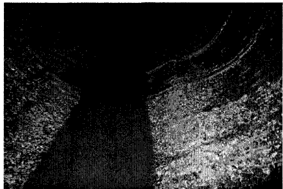
〈강관 라이닝 Buckling 발생〉
