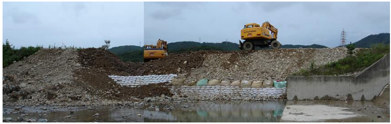
그림 6. 포항시 오천읍 용산리 냉천 제방복구 현장
