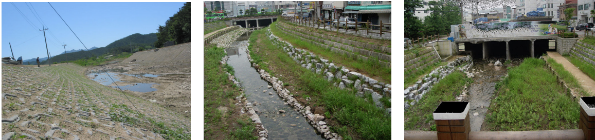
그림 9. 식생블록 및 식생옹벽 호안공에 식재된 식생의 활착 모습
