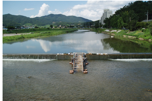
그림 5. 어도 설치 후 전경
