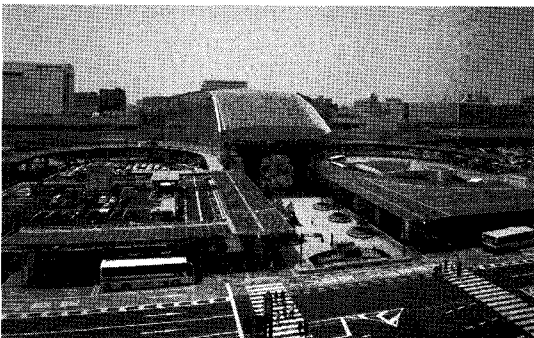
<그림 10> TSS 지붕 시공 예
