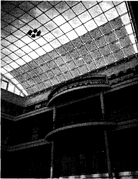
<그림 9> TSS 지붕 시공 예
