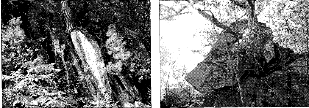
사진 1. 화강암의 수목에 의한 블록이완 상태(좌 : 사면내, 우 : 상부자연사면)
