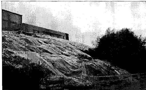
그림 1. 사면붕괴현황 사진
