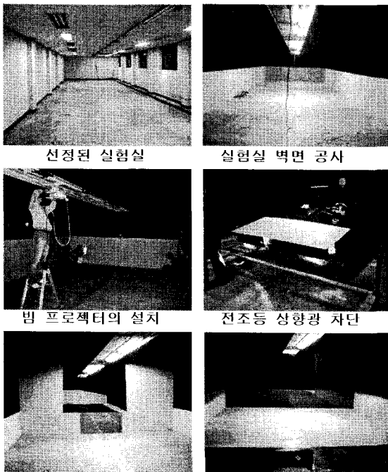
차광판설치 및 구역분할 실험실 페인팅 작업완료 그림 8. 실험실 공사과정
