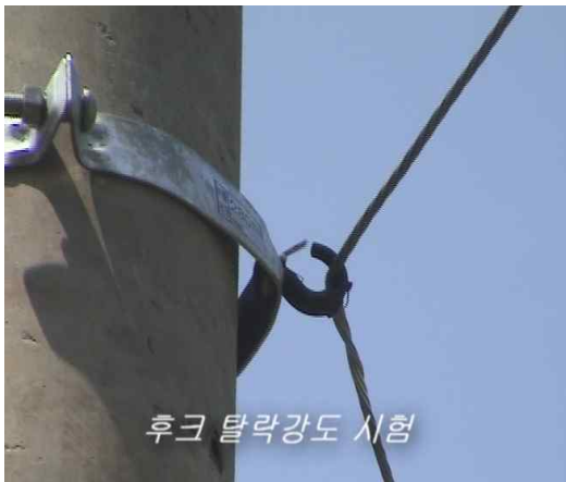
사진 2. 실제 인장강도 시험 장면
