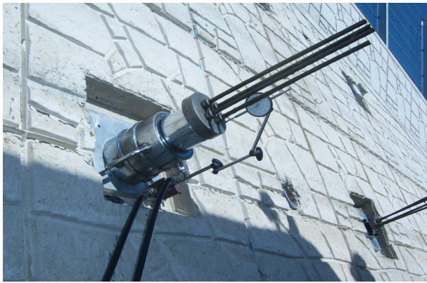
그림 7a. 현장 인발시험 전경
