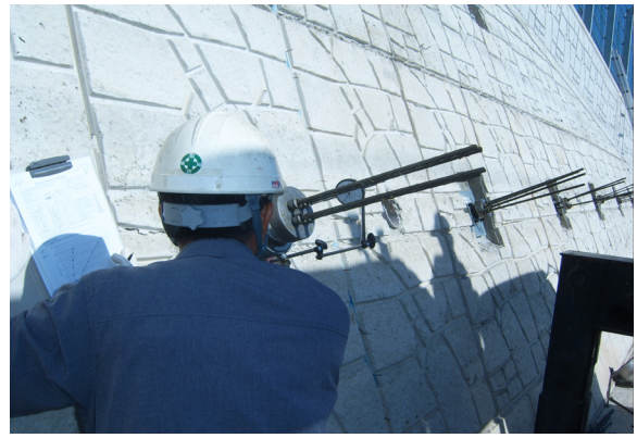
그림 7b. 현장 인발시험 전경
