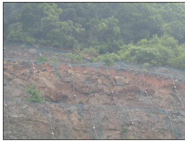
그림 3.3.2 소단부 표층파괴에 의한 토사유실 및 낙석발생
