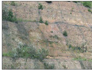
그림 3.3.2 소단부 표층파괴에 의한 토사유실 및 낙석발생
