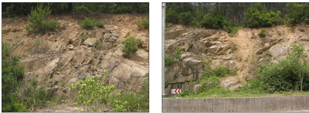
그림 3. B 사면의 풍화양상 및 토사화 진행
