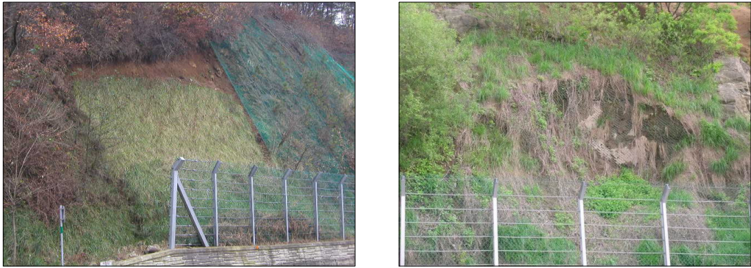
그림 10. 절토사면 내의 식생공 유실 전경
