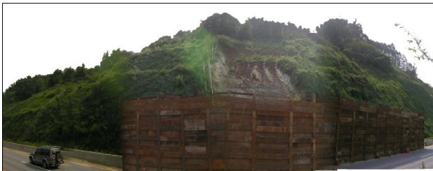
그림 3. 느릅재 절토사면 전경도 (1차붕괴 후)
