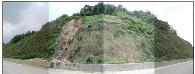
그림 4. 느릅재 절토사면 전경도(2차붕괴 후)
