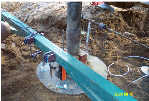
(a) 평판재하시험 장치 설치광경
