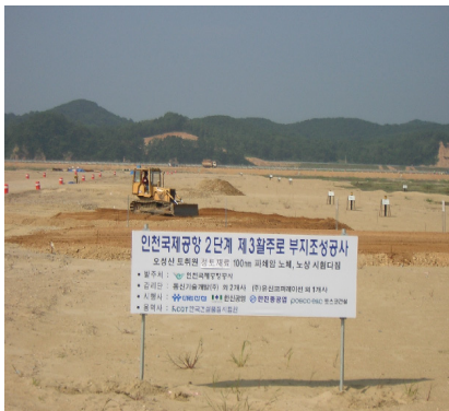
사진 3. 시험다짐 시공현장(성토재료 포설 ⇒ 진동롤러 다짐 ⇒ 타이어롤러 마무리 다짐)
