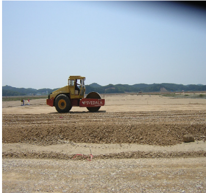
사진 3. 시험다짐 시공현장(성토재료 포설 ⇒ 진동롤러 다짐 ⇒ 타이어롤러 마무리 다짐)
