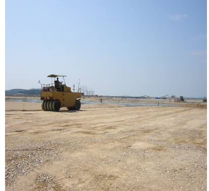
사진 3. 시험다짐 시공현장(성토재료 포설 ⇒ 진동롤러 다짐 ⇒ 타이어롤러 마무리 다짐)
