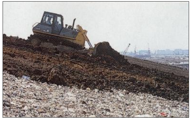
<그림 1.1> 좌 : 석산의 골재채취 전경 우 : 쓰레기 매립장의 복토재 시공
