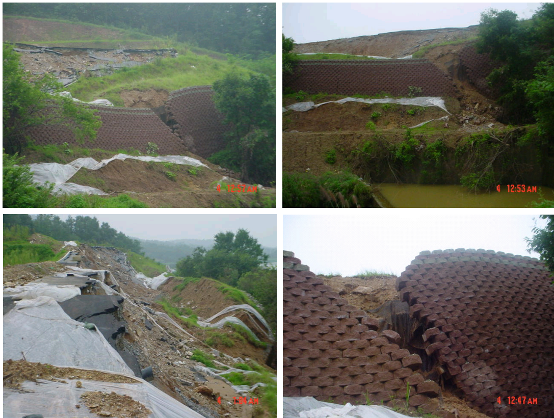
그림 1. 붕괴된 보강토 옹벽의 주변상황 사진
