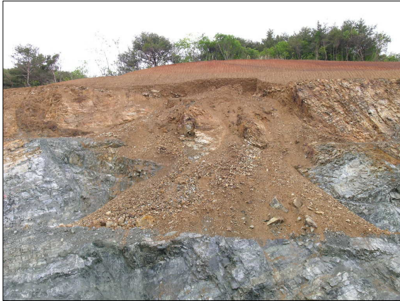
그림 4. 단층발달에 의한 사면붕괴
