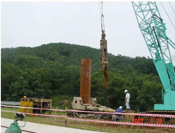
그림 3. 현장타설말뚝 시공 장면 : 베노토 공법
