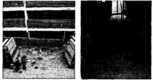
(a) 시발파진동 계측 전경
