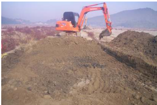
(a) 시험시공 노선 터파기
