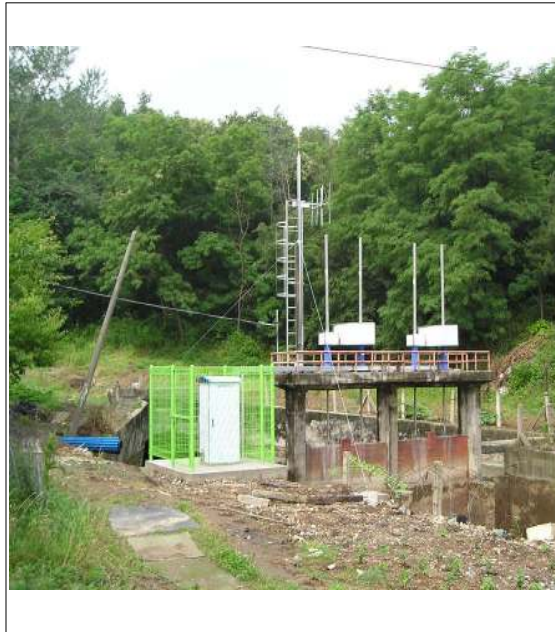
<그림 5> 문비가 낡아 actuator작동이 불안함
