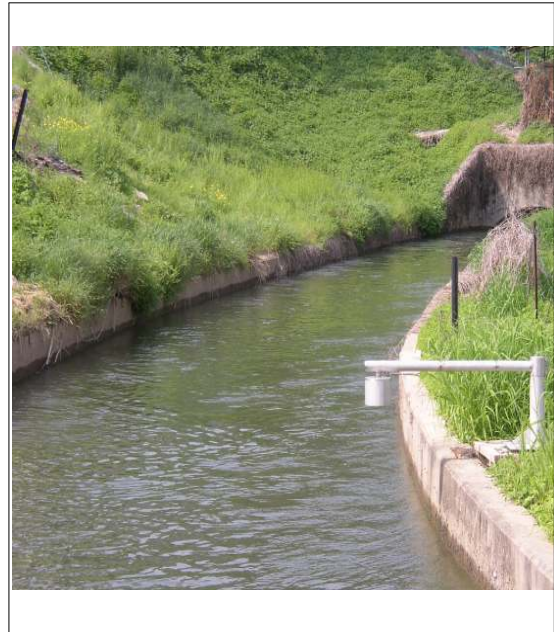
<그림 6> 개수로에 설치된 초음파 수위계
