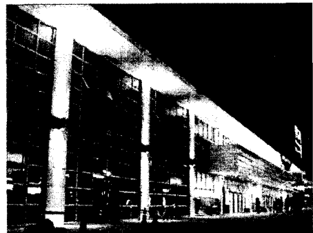
그림4. 부분 이미지-출입구 강조조명 Fig. 4. Partial Image-Entrance Accent lighting
