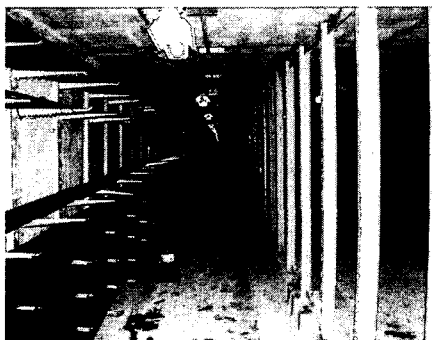
그림 1. 공동구의 내부 시설
