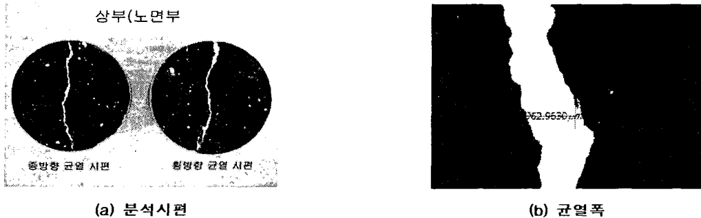
그림 2. 화상처리에 의한 균열폭 측정
