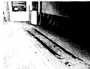
사진 6 지하주차장 입구에 설치된 전동차수벽
