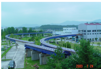
그림 4. 기계연구원내 자기부상열차 평행이동식 분기기
