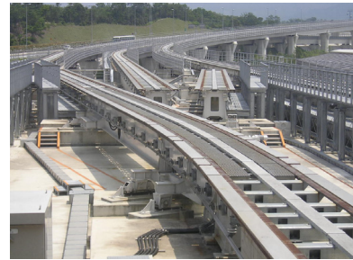
그림 3. 일본 HSST 시스템의 다관절 굴절식 분기기
