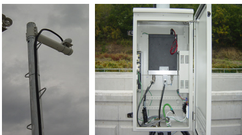
그림 7 CBTC용 안테나 및 장치
