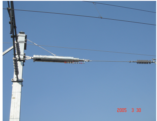
자동장력 조정장치의 설치 전(WTB)/후(KRSB)
