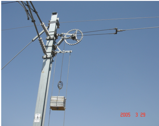
자동장력 조정장치의 설치 전(WTB)/후(KRSB)
