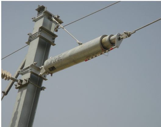
자동장력 조정장치(KRSB)의 설치 운영 및 눈금자
