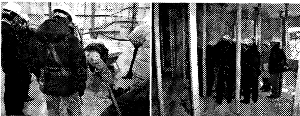
사진 8. 굳지않은 콘크리트 및 경화 콘크리트 현장조사
