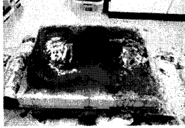
15. 유리섬유 위에 FRP를 도포한 상태 FRP가 완전히 굳을 때 까지 기다린 후 재차 FRP작업을 실시함
