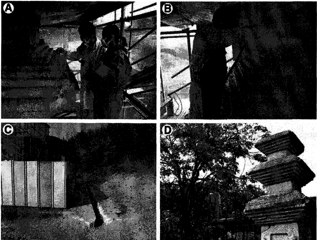
그림 3. 경주 서악리 삼층석탑의 보존처리. (A) 증류수를 이용한 세정. (B) 고온스팀을 이용한 세정. (C) 석탑 동측에 설치된 배수로. (D) 주변 수목 제거.
