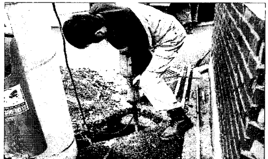
[그림 3.2] 브레카로 접지봉 타격 시공
