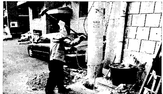
[그림 2.1] 사람이 망치로 접지봉 타격 시공
