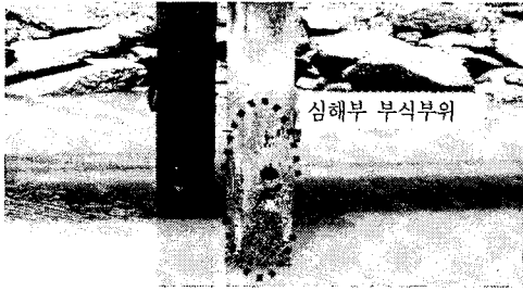
사진 3. 심해부 교각부식 사진
