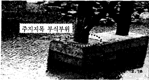
사진 2. 주지지목 부식 사진
