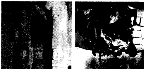
그림 1. 뇌썬지 및 사고전류에 의한 SVL 파손 사진
