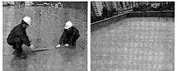
5. 조인트접착 테이프 시공
